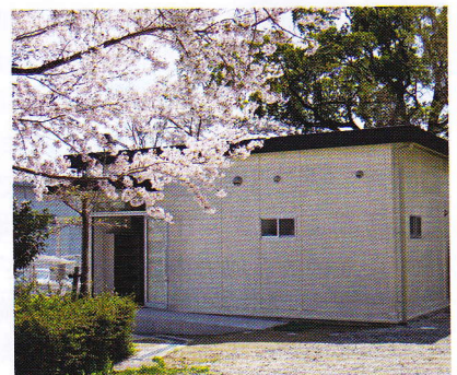
(新設された施設)
